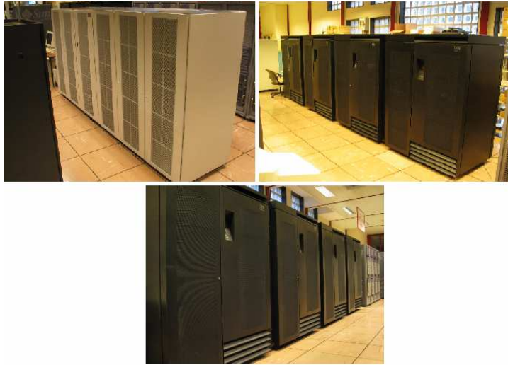
Figure 4.5 : stockage sur disques
