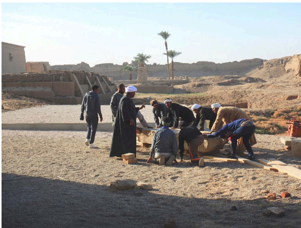
Fig. 8. Déplacement d'un bloc épars, documenté et enregistré, du mammisi vers une banquette de stockage aménagée par la mission (P. Zignani).
