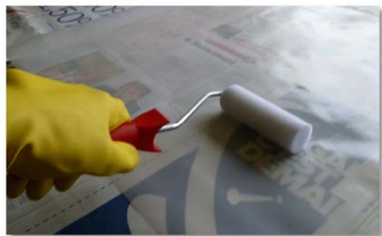
Figure 6.14 : Application du silicone sur la feuille de papier calque à l'aide d'un rouleau de peinture.
