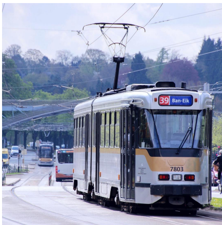
FIGURE 1.3 – Prise d'électricité à l'aide d'un pantographe sur une ligne aérienne
