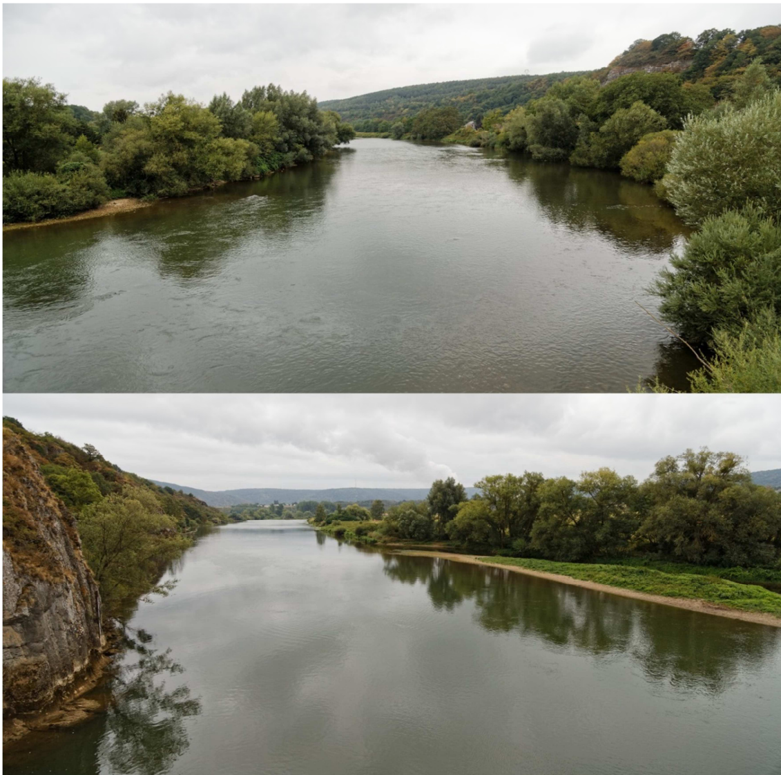
Figure 18 : Vues générales de la Meuse à Ham-sur-Meuse depuis l'amont (haut) et l'aval (bas) du pont (50°06'53.2"N, 4°47'05.6"E)
