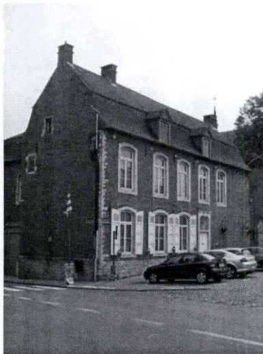
Le presbytère de Grez-Doiceau, sur la place Dubois Habitation de la 2 e moitié du 18 e siècle en briques et grès. (Photo de M.-A. Collet, 2007)
