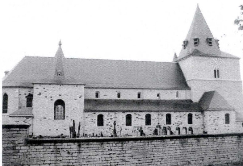
L'église Saint-Martin de Tourinnes-la-Grosse, classée depuis 1946, après les travaux de restauration (2008-2010) (Photo M.-A. Collet, novembre 2010)
