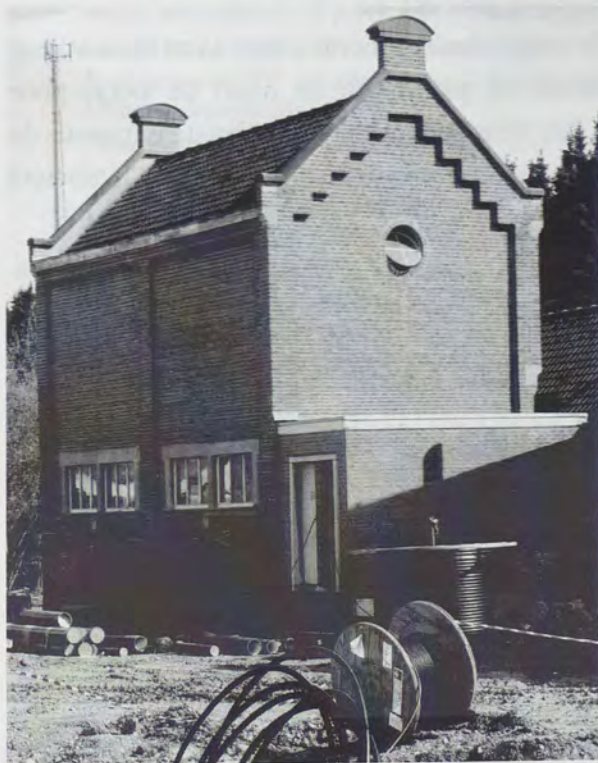
Vue partielle de la première station de pompage de Jambes. Cliché F. Jacquet-Ladrier.
