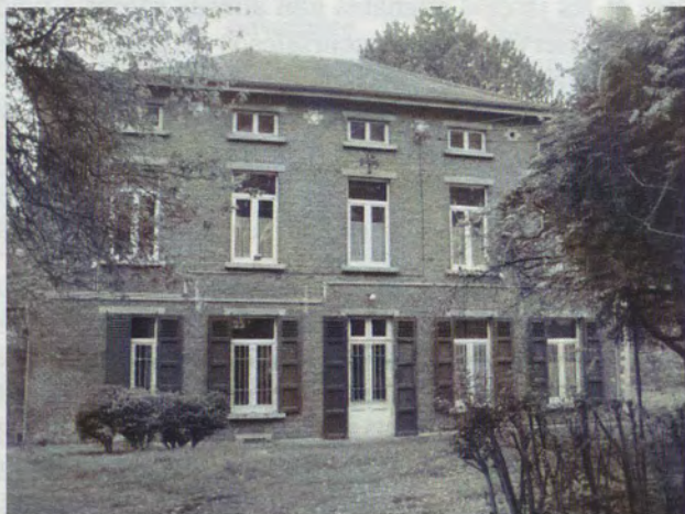
Presbytère de Baulers (Nivelles) (Photo M.-A. Collet, novembre 2012)
