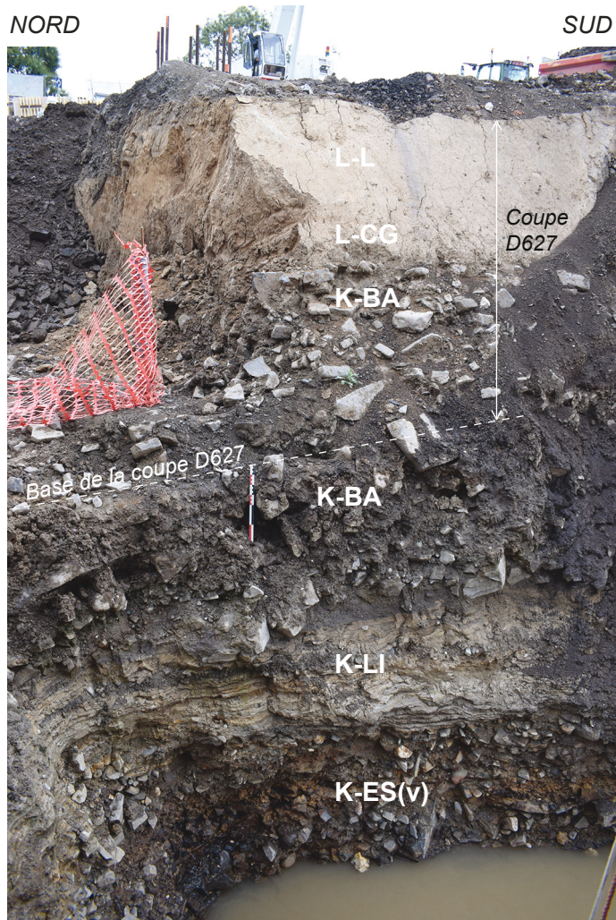
Fig. 14 – Terrassement mécanique réalisé par l'aménageur au pied de la grande coupe nord-sud du secteur 14 (D.627), et observée le 08/08/2018 par une archéologue de l'équipe. C'est le seul endroit du site où l'unité K-Li a été observée. L'échelle au centre du cliché fait 40 cm. Cliché : S. Loicq ; infographie : S. Pirson ; © AWaP.
