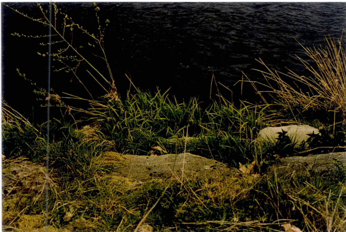
Figure 16 : Enrochement d'une berge de la Lesse entre Villers-sur-Lesse et Ciergnon.
