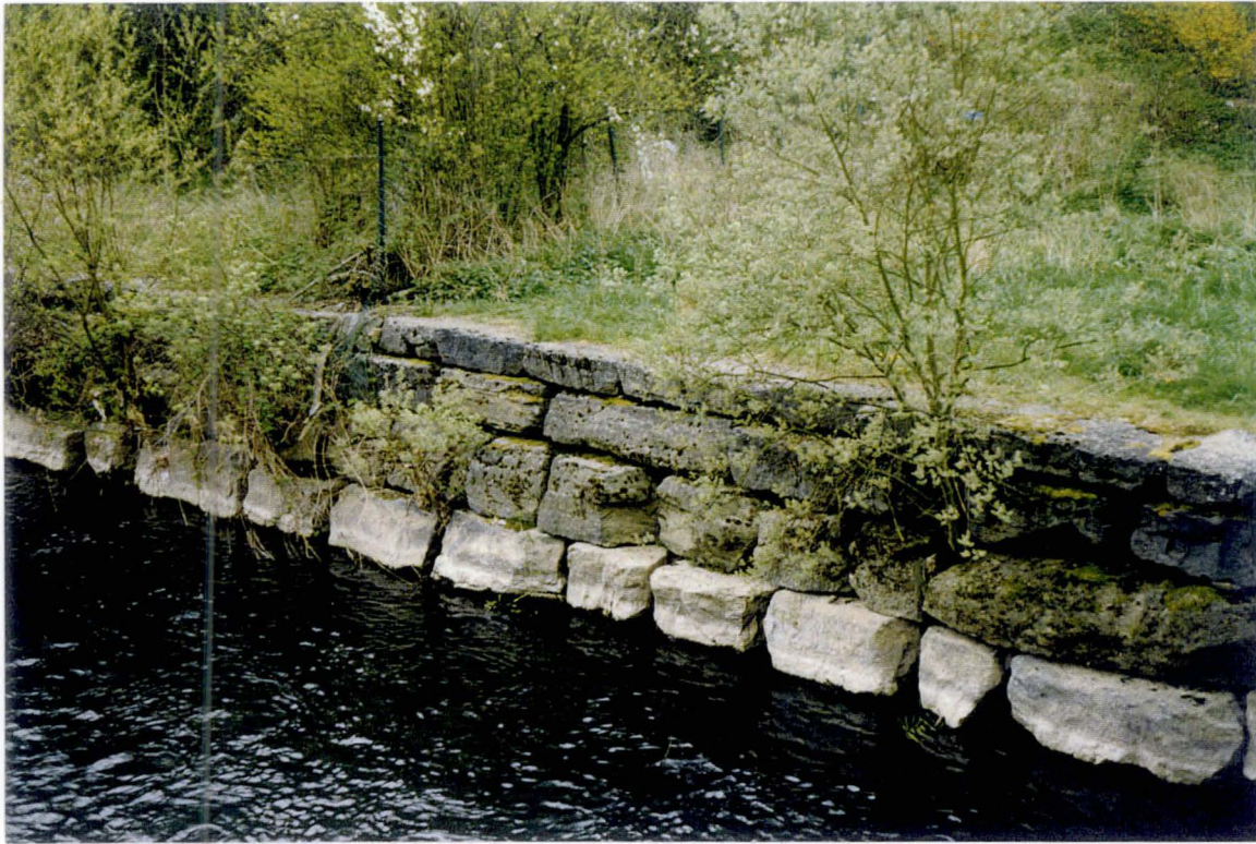
Figure 15 : Enrochement d'une berge de la Lomme.
